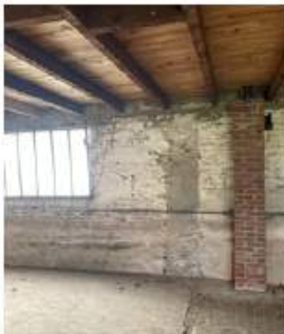
RDC // Future entrée
