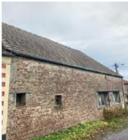
RDC // Future entrée (côté extérieur)
