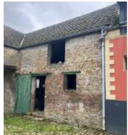
RDC // Futur accès Cour intérieure
