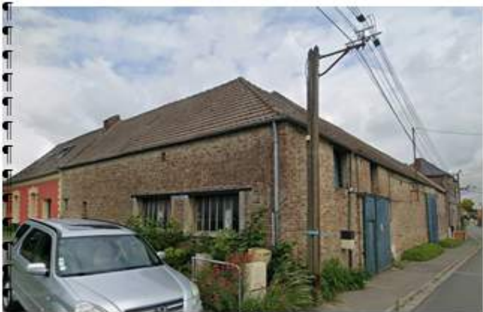
Photo du bâtiment existant
