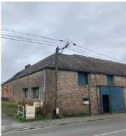
Façade de l'existant sur rue
